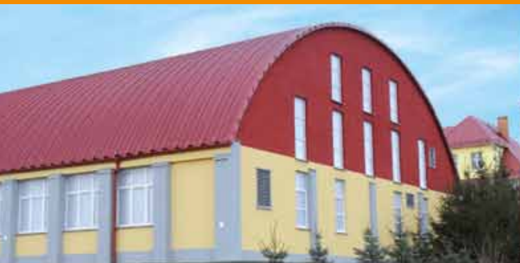
Hala sportowa w Marcinowicach z układem GEO-KLIMAT
